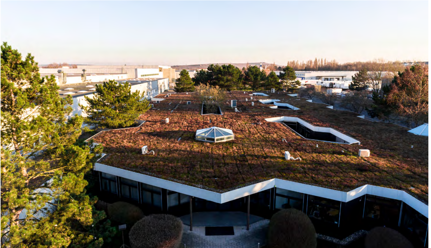
mac-Campus in Langenlonsheim • Begrüntes Dach
